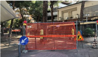
Riccione. Viale Ceccarini, partiti i lavori alla pavimentazione
